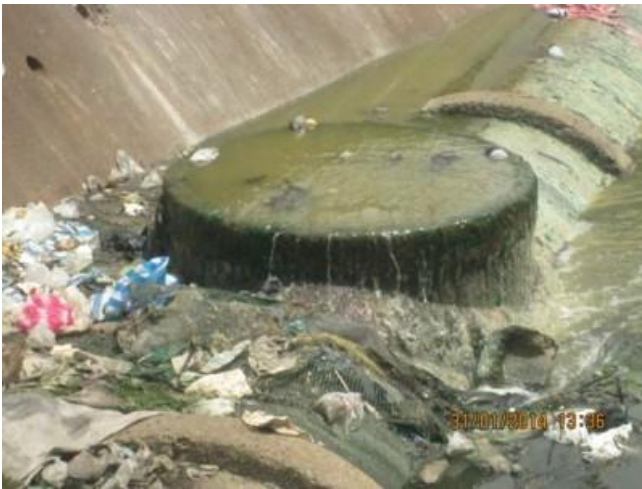
Figura 7. Shpërthimi i tubacioneve të ujërave të zeza në përmytje me lëndë fekale.
